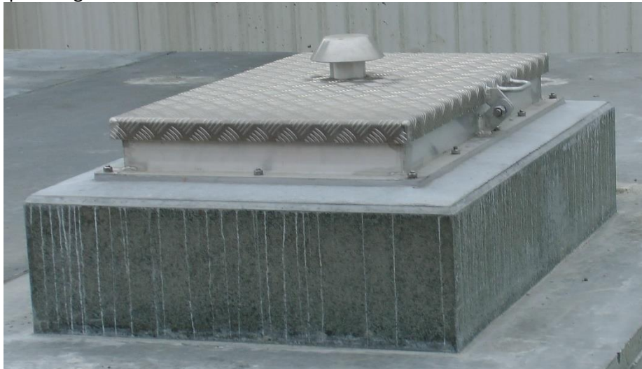
Figur 4 viser alu dæksel monteret på en opkant.
