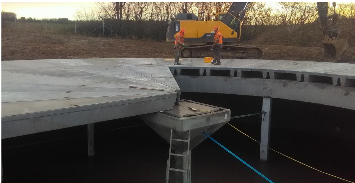
Figur 9 viser montage af inderste omgang A dæk ved model C.
