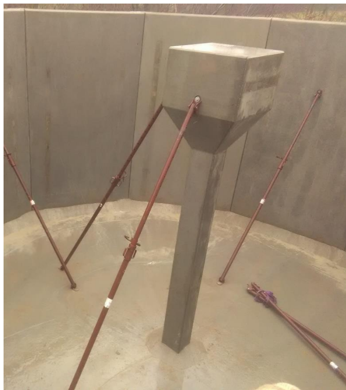
Figur 2 viser en monteret centersøjle med understopning.
