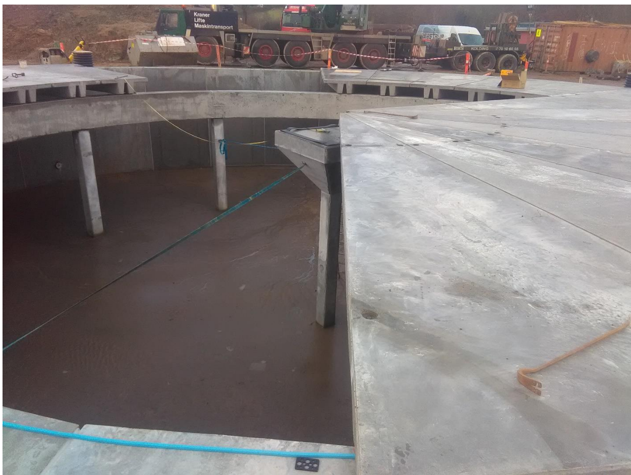
Figur 10 viser placering af plastbrikker og Aqua Tack Seal fugebånd under montage af model C.
