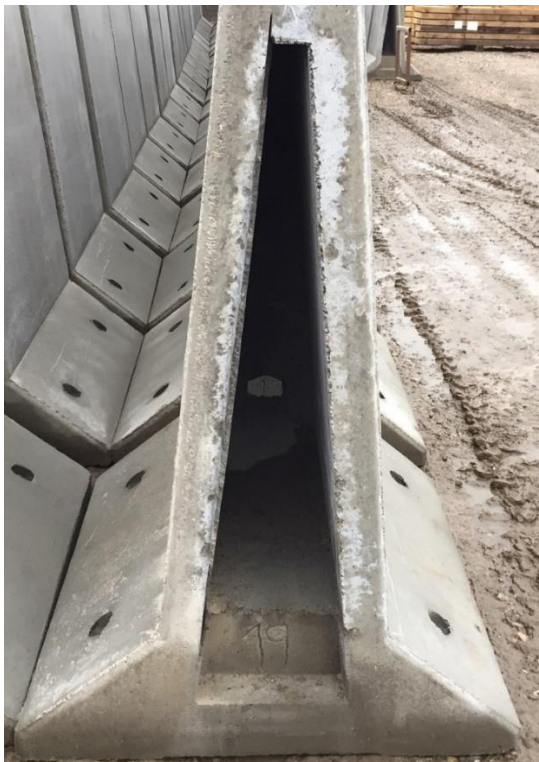
Figur 2 viser A-elementet fra siden, dornhuller ses på hver side af elementet.
