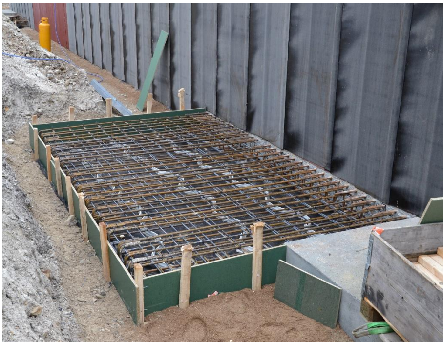
Figur 4 viser armeringsarbejde til fod på fløjmur.
