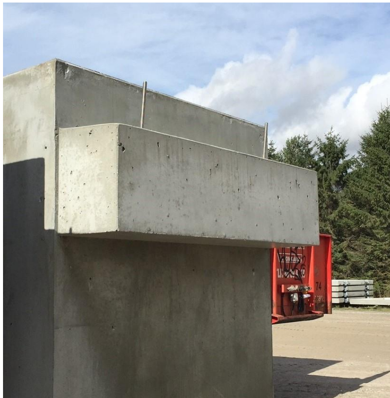
Figur 3 viser konsol på elementside til aflastningsplade.
