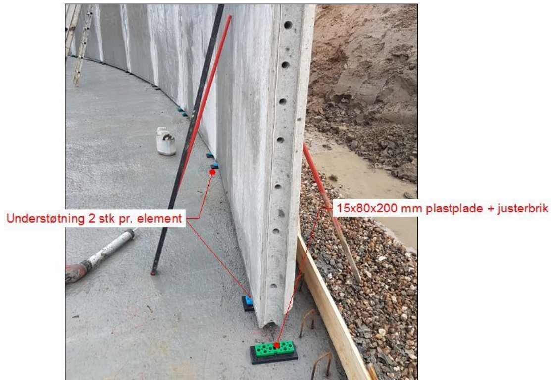
Figur 8 viser placering af plastplader til understøtning.
