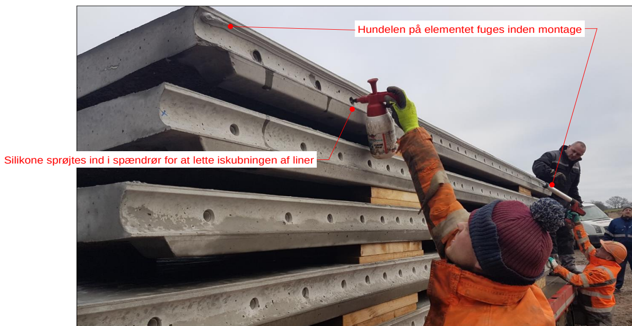
Figur 6 viser brugen af fugemateriale og silikone.
