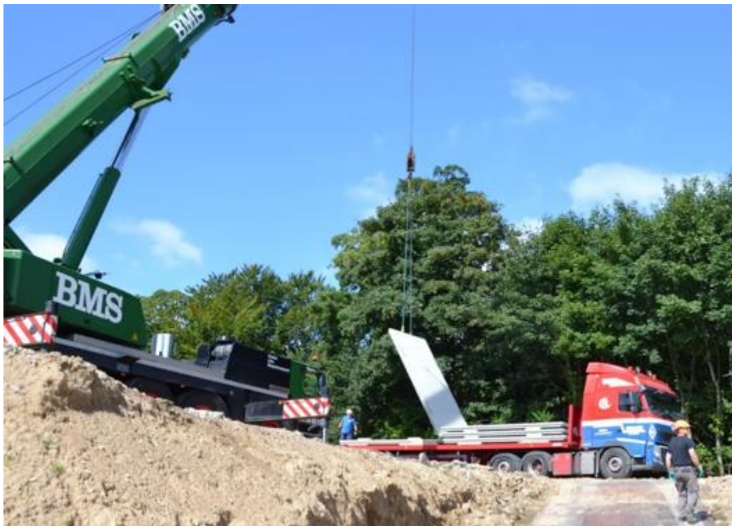
Figur 13 viser elementer som kranes fra lastbil
