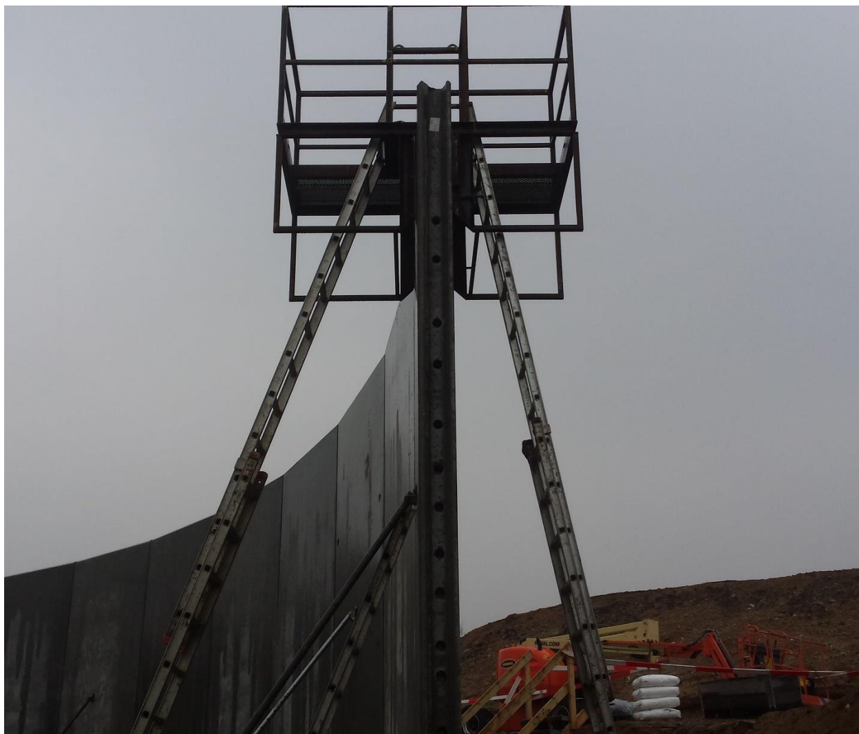
Figur 10 viser platformen monteret på tanken.
