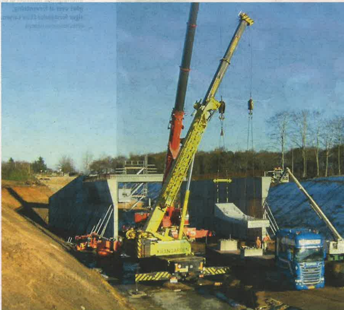
○ Betonelementerne på siderne af den kommende bro over Videbækvej er ved at blive sat op. Om to uger sættes elementerne til brodækket op. FOTO: VERNER LAURITSEN
