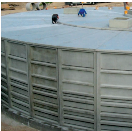
Bassin til afledning af spildevand ved voldsom regn for Forsyning Ballerup A/S.
