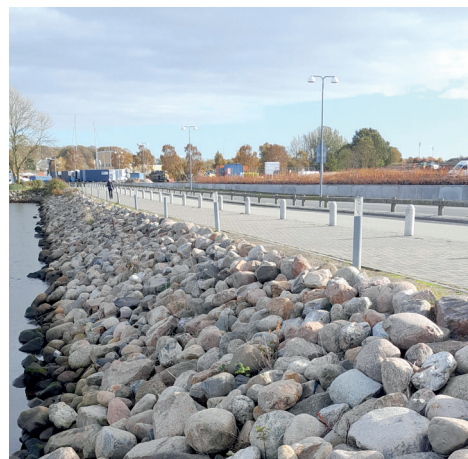
Stormflodssikring af CityCamp Assens Strand, støttemur af L-elementer.
